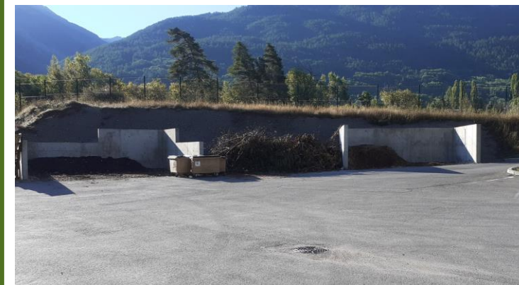
Plateforme de compostage et de broyage du quai de transfert
