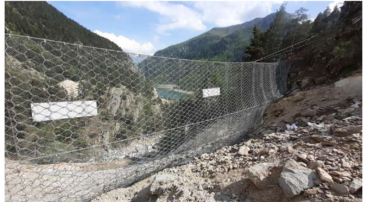
Mise en œuvre d'un écran pare-blocs provisoire de 5000 kJ
