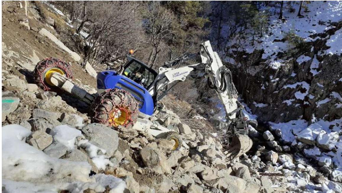
Minages et purge du glissement à la pelle araignée
