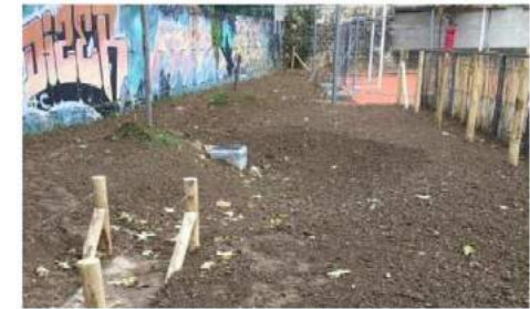
Création de fossé
