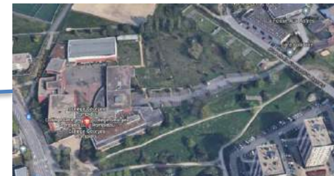
Collège Pompidou - Villeneuve-la-garenne
