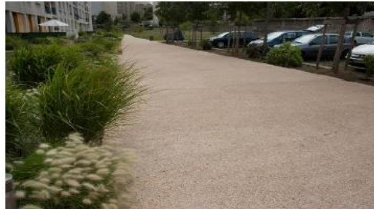
Béton drainant (cour, circulations piétonnes en pente)
