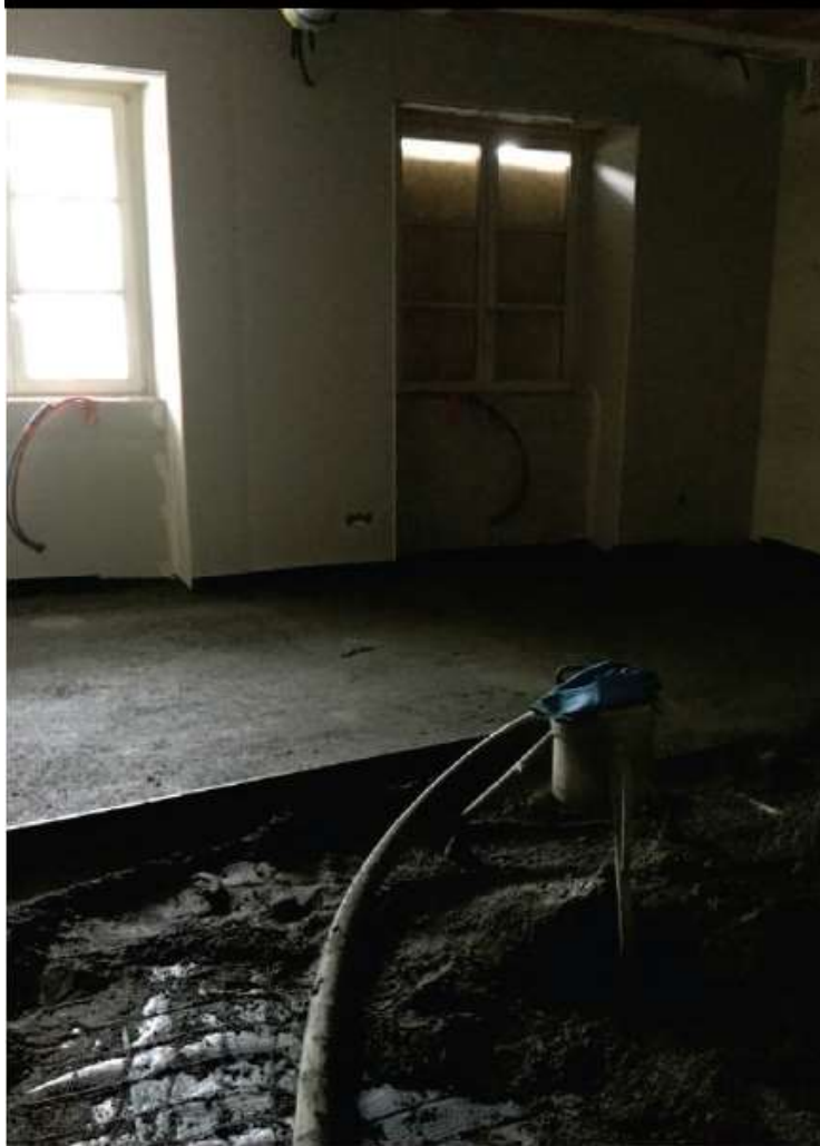
ECOLE : Chape et plancher chauffant
