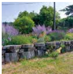
Saint-Michel-de-Montaigne À l'initiative de l'agent communal, mur de soutènement réalisé avec des chutes de bois issues de la scierie locale.
