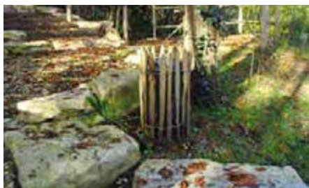
Montpon-Ménéstérol - Enrochement de pierres locales qui permet de descendre en toute sécurité au bord de l'Isle.
