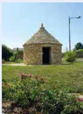
Cabane en pierre sèche à Hautefort
