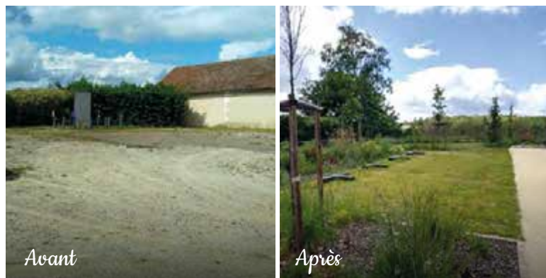
Fouleix : avant/après, mélange terre-pierre et noue végétale
