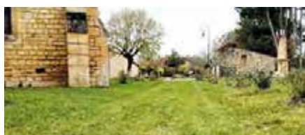
Voie carrossable avec maille « Grass Protecta » à Saint-Chamassy
