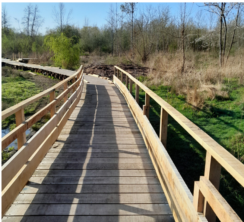
Construction du platelage - 2023
