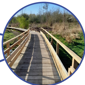
2023 - Réalisation du platelage
