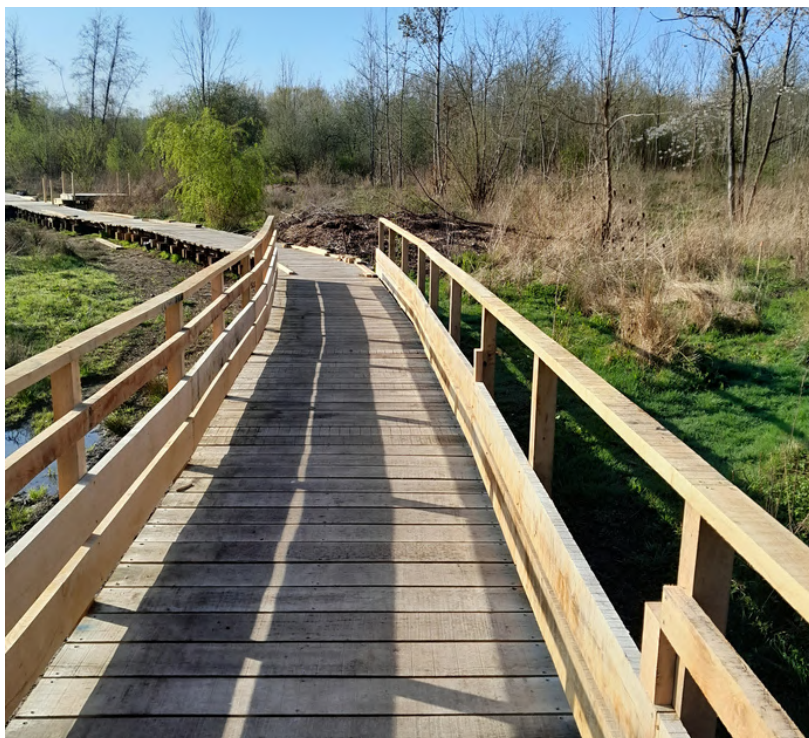
Construction du platelage - 2023
