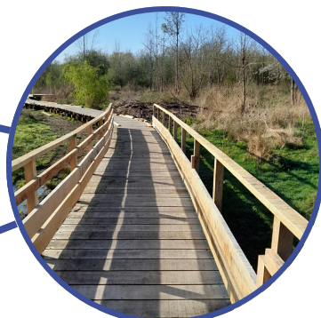
2023 - Réalisation du platelage
